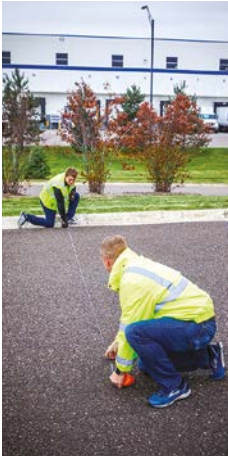
Método tradicional: Requiere un cordel, tiza y 2 personas
